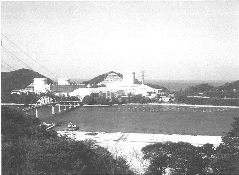
我が国最初の加圧水型原子力発電所
