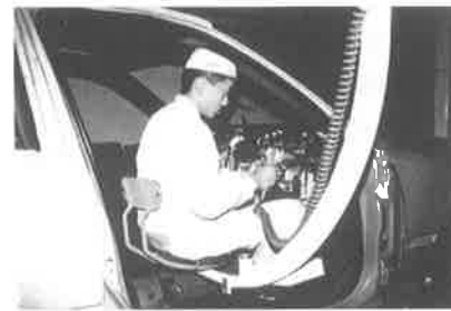
腰痛予防の姿勢点や腓骨神経麻痺予防の下肢点のcheckからaction(生産技術的対応)が生まれた —自動車組立ラインに開発されたらくらく作業シート—1992年
