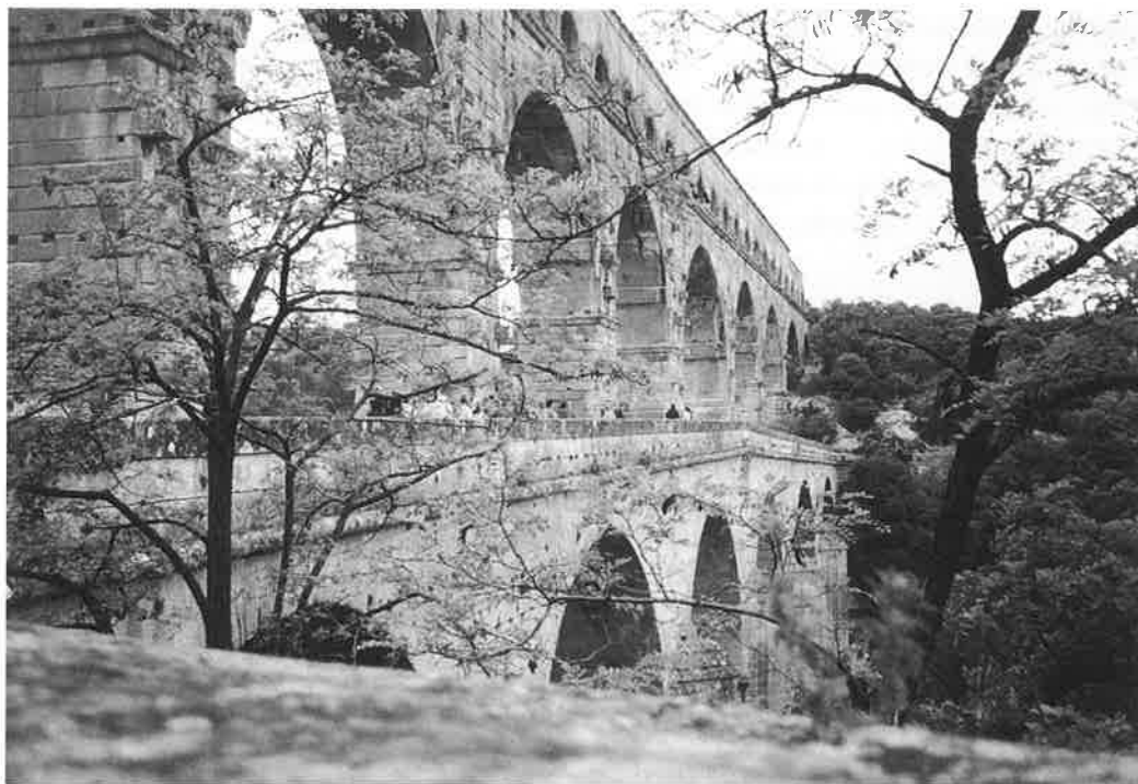
ポン・デュ・ガール：南仏アヴィニヨンの近くに残っている紀元前19年頃のローマ時代に建造された巨大な水道橋（長さ275m、高さ49mの3層構造で、最上部が水が流れていた。） 【小森義隆撮影】
