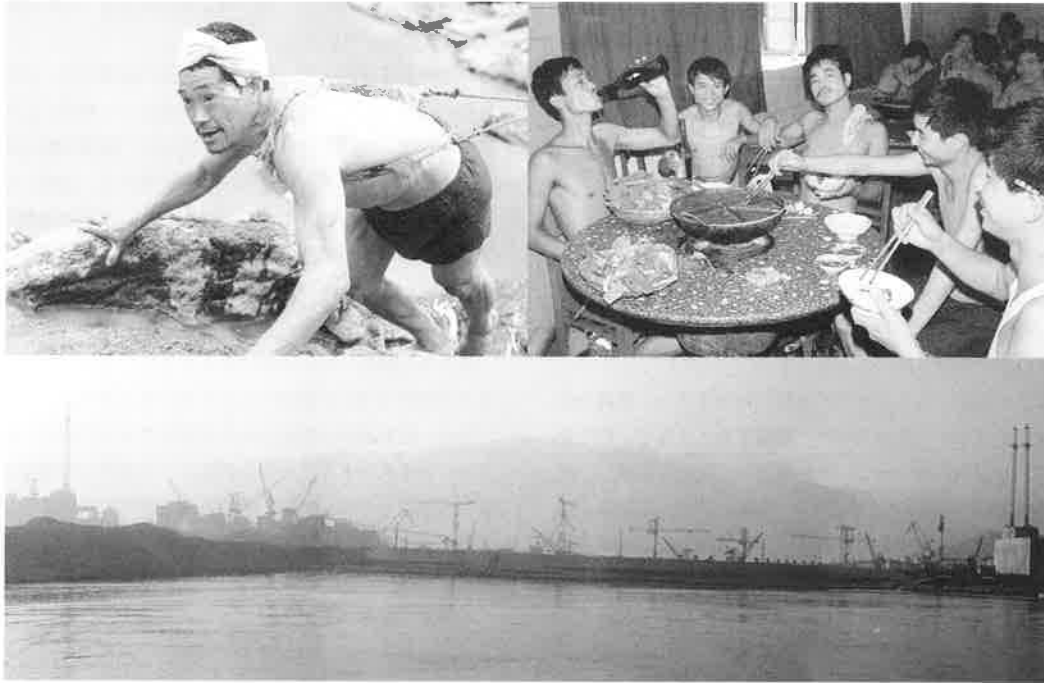
上段は、(左)「長江の船曳き人夫」と(右)「辛い四川料理を食べる労働者」(中国・四川人民出版社刊「長江三峡」1989年より) 下段は、三峡ダム建設現場(筆者写す)
