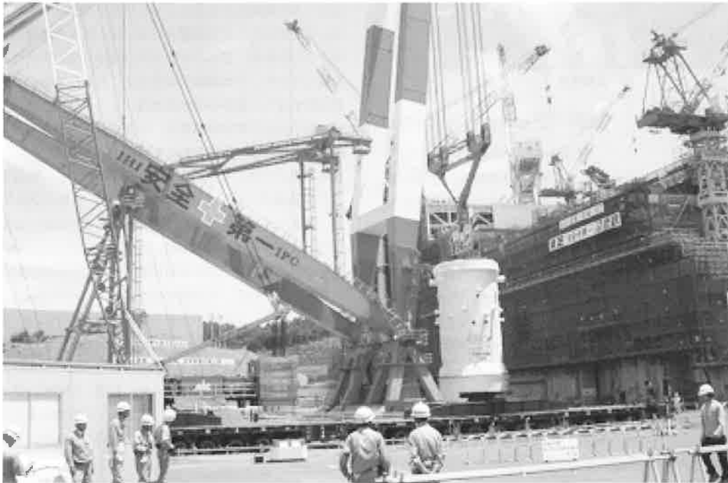
建設中の浜岡発電所5号機
