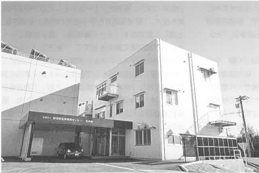
静岡県産業環境センター分析棟
