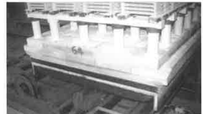
焼成工程前の台車のクッションに石綿を使用
