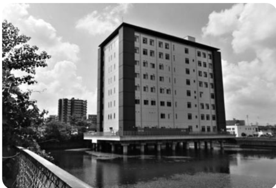
【写真1】大府駅至近の池の中に建設された8階建ての看護学部・看護学研究科
